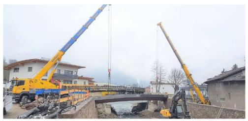
12/04 posato anche il concio "ovest" sempre composto da 3 travi NPS® Basic da 28 metri, da 6,5 tonnellate ciascuna, e come il precedente con successiva posa acciaio e getto di completamento.
