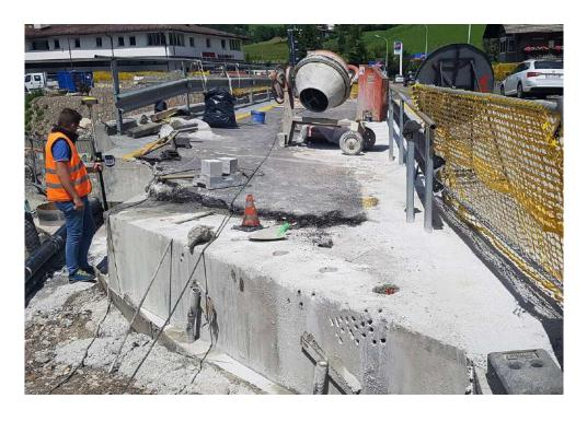
25/08 - A flusso ripristinato sul nuovo impalcato stradale, realizzato sul sito del vecchio ponte, i due conci laterali vengono spinti verso il blocco centrale e creato un unico grande ponte, solidarizzato con un getto, creando un ponte più ampio nelle careggiate, con marciapiedi e pista ciclopedonale.
