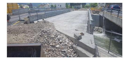
5/05 Collaudati i due ponti est (in foto in alto) e ovest, il traffico viene spostato sui ponti laterali e quindi demolito il ponte centrale (foto sotto).
